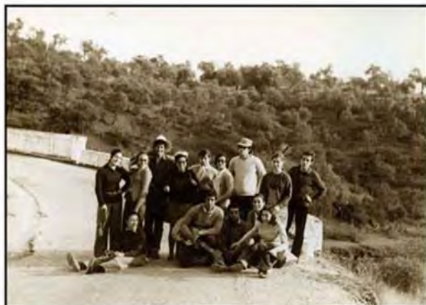
1.971 En el Puente de la Ribera
