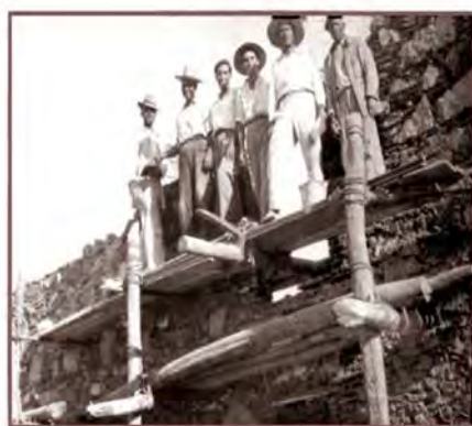
El Pedroso 1.951. Construcción de la casa de Carmen Moya en la Calle Queipo de Llano (En la actualidad Calle Prado) Antonio Martínez, José Bazo, Manuel García, José García, Francisco Pariente y Antonio Oliva
